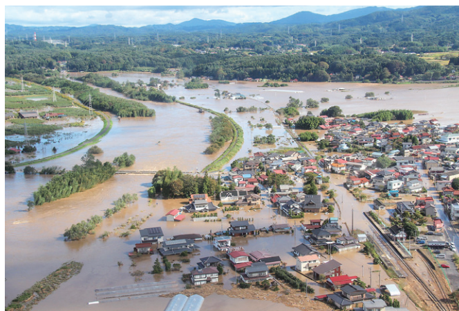
福島県須賀川市の浸水被害の状況（福島県消防防災航空隊提供）
